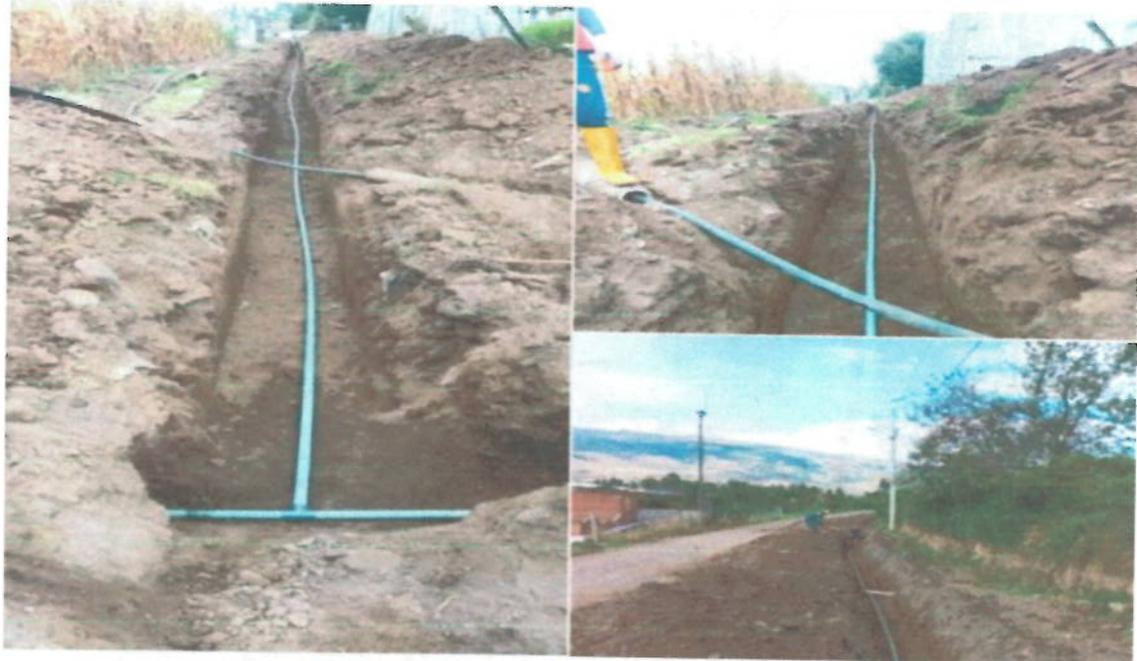
**AMPLIACIÓN DE LA RED DEL BARRIO LA YEE, TUBERÍA PVC 32MM,
